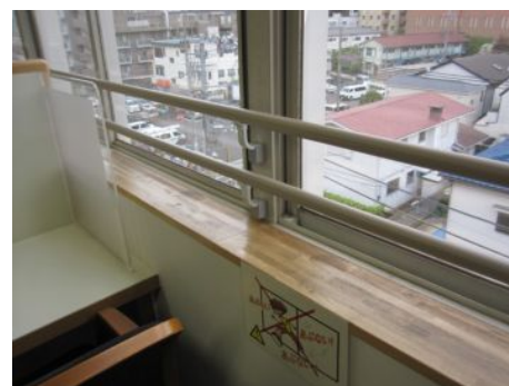
事務棟各部屋の手すり
